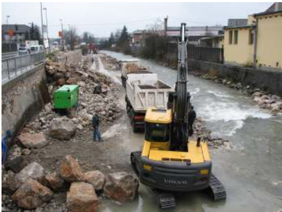
Slika 4. Regulacijska dela na Kamniški Bistrici v Kamniku, marec 2007 (foto: Arhiv ARSO) Figure 4. Regulation work on the Kamniška Bistrica River in Kamnik, March 2007 (photo: Archives of ARSO)
