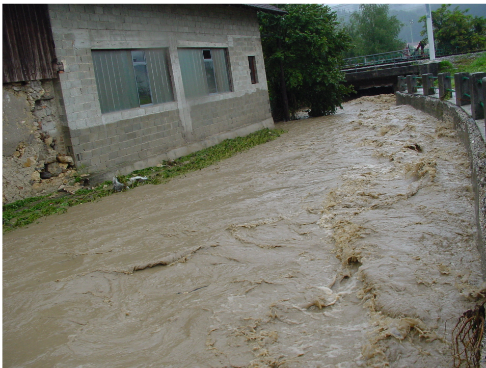
Slika 3: Na gradbenem objektu vidna sled najvišje vode Sevnične v Sevnici dne 21.avgusta 2005 ob 12:38. (foto: Jože Uhan)
